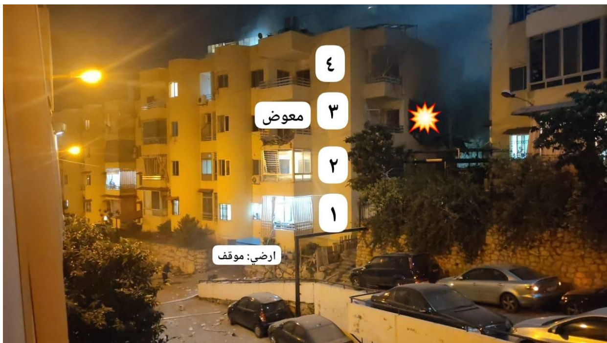
صورة المبنى المستهدف تحدد الشقة المستهدفة
